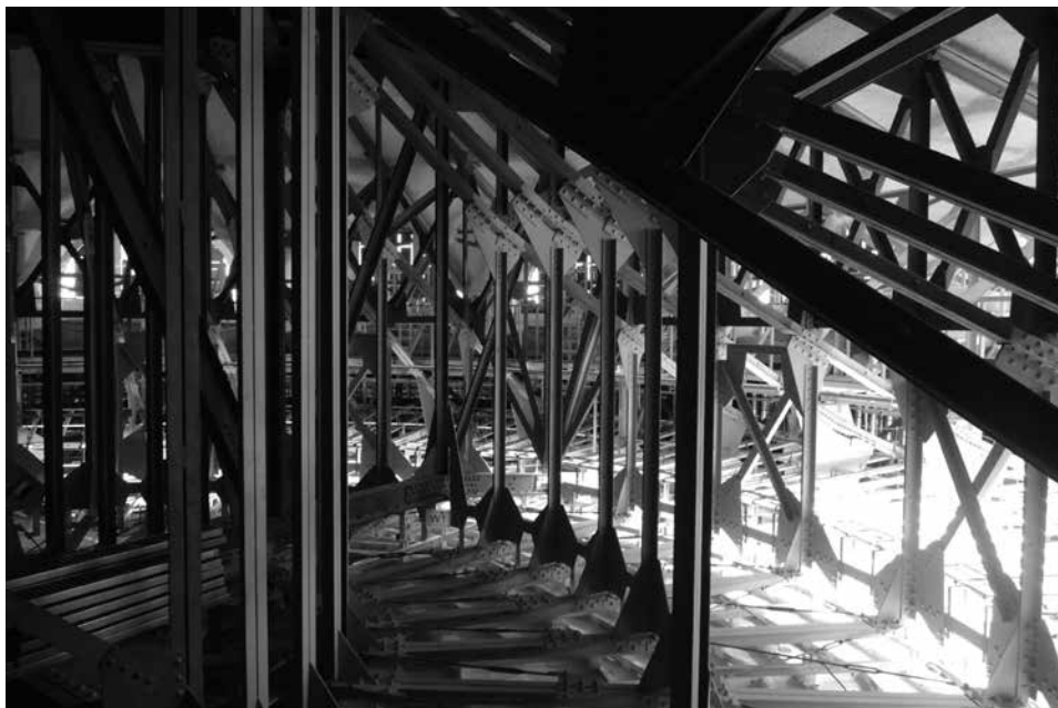
吊天井から固定天井へ (写真提供 (有)香山壽夫建築研究所)
