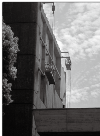
ゴンドラで北側外壁の復旧作業を行う様子
