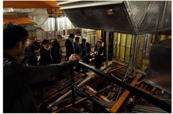
大ホール 天井
