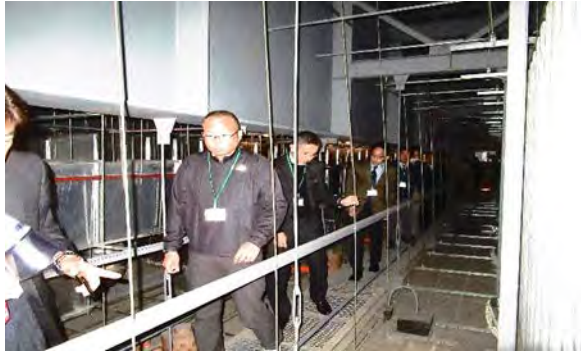
天井裏の見学
