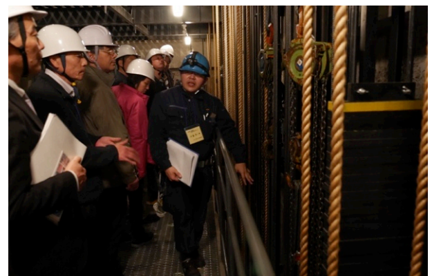
改修現場見学（ワイヤーロープ交換の状況説明）
