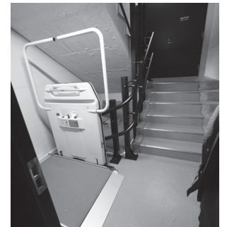
バリアフリー化のために車椅子用階段昇降機を設置した
