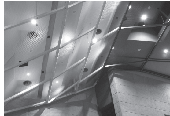
新設したフレームに張られた落下防止用ネット
