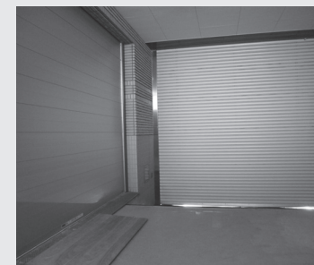
楽屋側、搬出入口のプラットフォーム部分にシャッターを設置
