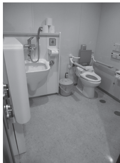
改修更新された多目的トイレ
